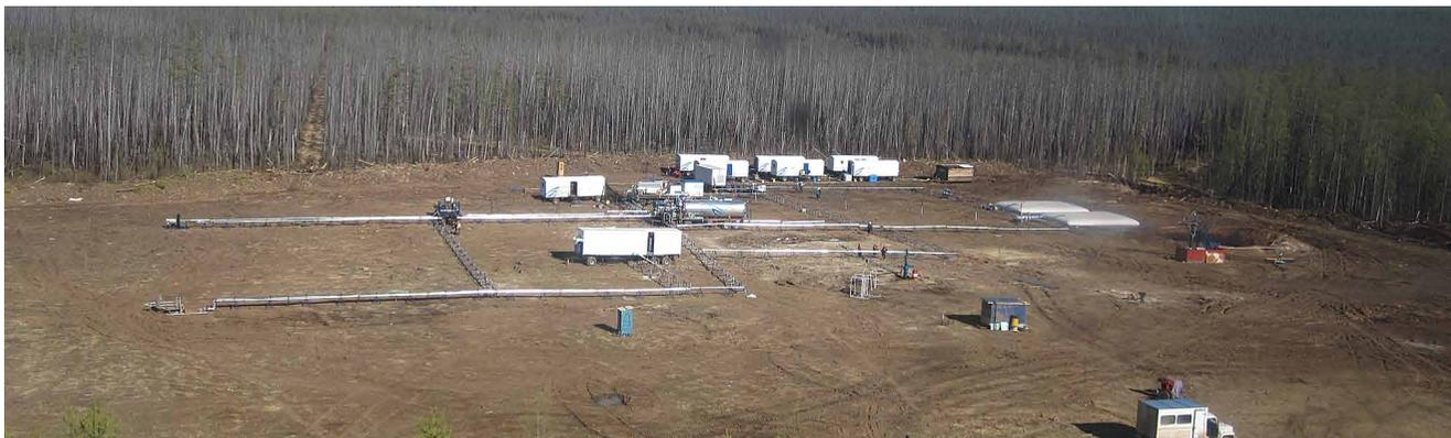
Наличие подобного комплекса, изготовленного по техническому заданию заказчика, позволяет на начальной стадии испытания разведочных или эксплуатационных скважин, в условиях полного отсутствия инфраструктуры и автономии, имея скважину дающую продукцию, осуществить ее испытания или эксплуатацию, а также обеспечить работу мобильного энергоцентра на базе газопоршневых, газотурбинных или дизельных агрегатов, таким образом развивая любую необходимую инфраструктуру по принципу конструктора «ЛЕГО».
