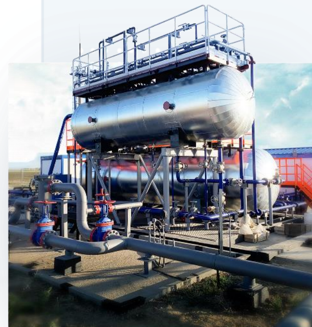
Мобильная установка предварительного сброса воды для ООО СП «Волгодеминойл»
